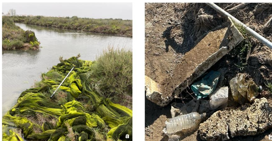
Figura 4. Desobstrução dos canais pela remoção de algas (a) e retirada de lixo marinho (b)
